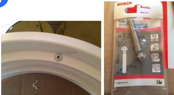
Damit die Köpfe der neuen Schrauben bündig im Deckenring sitzen werden die aufgebohrten Bohrlöcher mit einem Senkkopf erweitert
