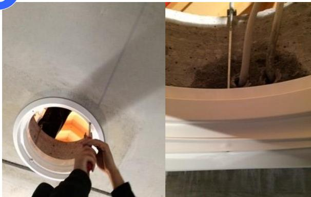
Nach Tausch der Schrauben den Deckenring in die Betondecke einsetzen. Die Verschraubungen gleichmäßig und nicht zu fest anziehen. Dabei ggf. zu Beginn die grauen Befestigungswinkel festgehalten, bis sie auf der Oberfläche Halt finden.
