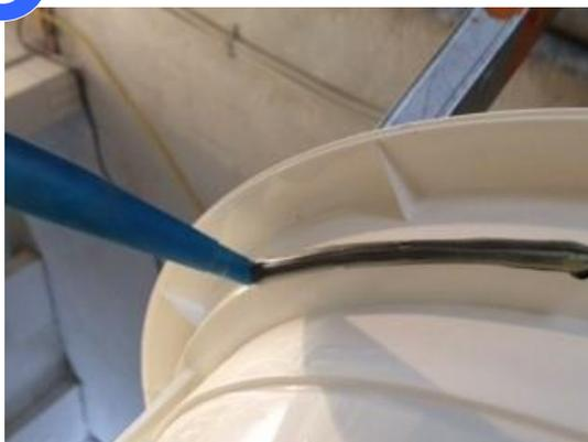
Zur Sicherstellung der Dampfdichtheit hat der Einbau luftdicht in die Betondecke zu erfolgen. Dazu hat sich in der Praxis das Einsetzen bzw. das Einkleben des Deckenrings mit dem Dichtungsband
