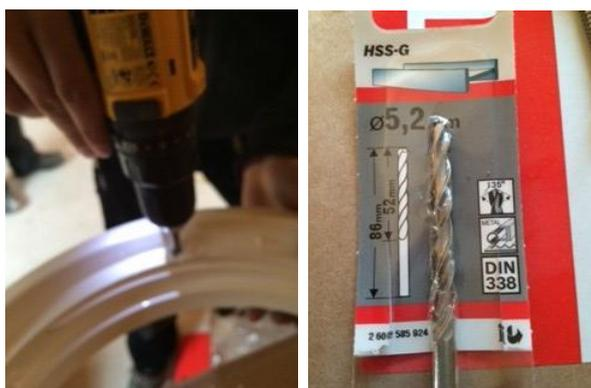
Um längere Schrauben in den Deckenring einzubringen werden die vorhandenen Lochbohrungen des Deckenrings aufgebohrt.
