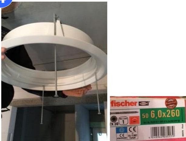
Nun die längeren Schrauben in den Deckenring einschrauben und die grauen Befestigungswinkel aufschrauben.
