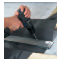
Az öntartó vízlevezető csatorna elvezeti a vizet az ablaktól
