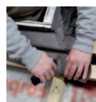
Az alátétfólia pontosan passzol az ablaknyílásra
