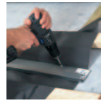
Az öntartó vízlevezető csatorna elvezeti a vizet az ablaktól
