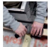
Az alátétfólia pontosan passzol az ablaknyílásra
