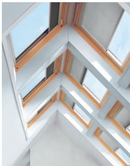
Gerinc mentén történő beépítés belülről
