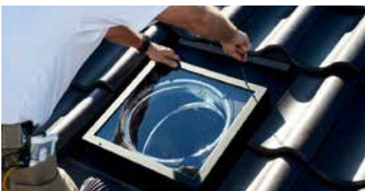
Montaż od strony dachu zapewnia wyjmowane skrzydło
