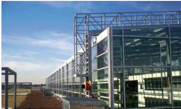
Gebruik van een mobiel platform
