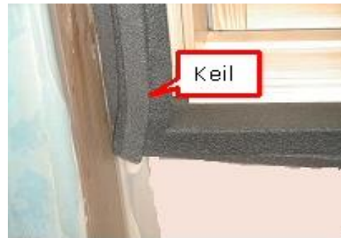
Die Keile dichten den Abstand zwischen Fenster und Konturlatten bzw. Hilfsplatten ab.
