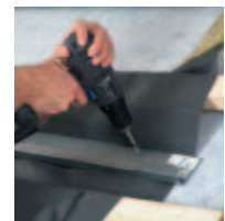
Az öntartó vízvezető csatorna elvezeti a vizet az ablaktól
