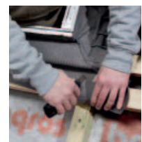
Az alátétfólia pontosan passzol az ablaknyílásra
